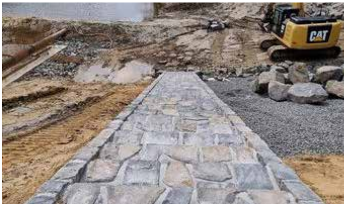
Na Kyjovské přehradě se začala budovat přístupová schodiště pro sestup k vodě.
