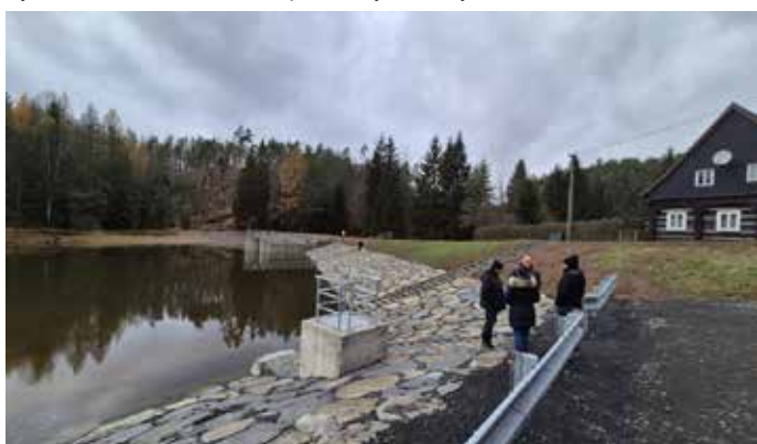
V listopadu jsme po rekonstrukci začali přebírat Kyjovskou přehradu od zhotovitele.
