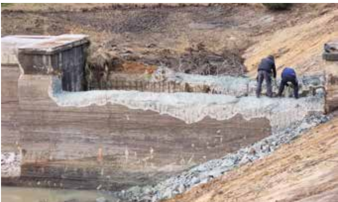
Na Kyjovské přehradě pokračovaly rekonstrukční práce opravou výpustného tělesa.
