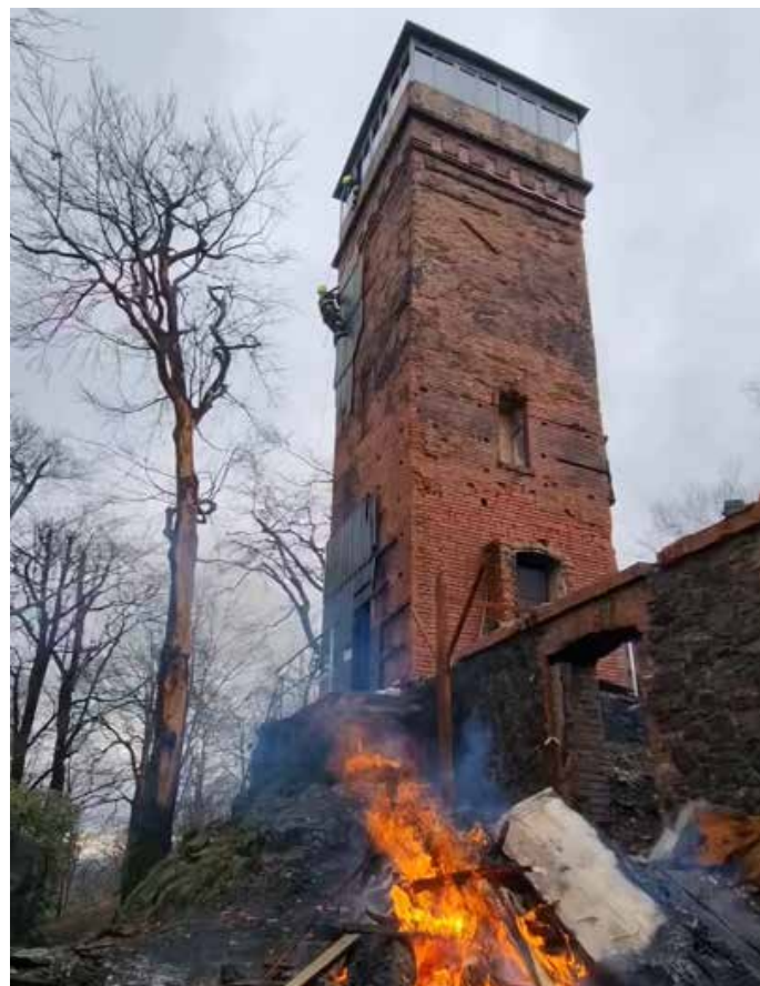
Krásnolipští hasiči spolu s členy KČT opět pokračovali v úklidu požárem poškozené rozhledny na Vlčí hoře.
