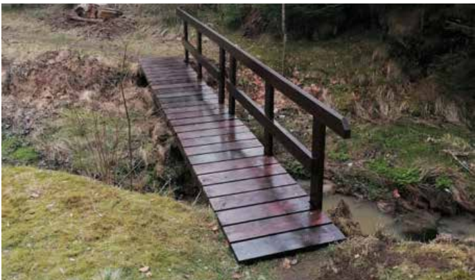
Naše TS obnovily lávky na Sýrovém potoce pod Kyjovskou přehradou.
