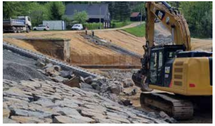
Zpevnění hráze na Kyjovské přehradě je provedeno kamennou rovininou z čediče.
