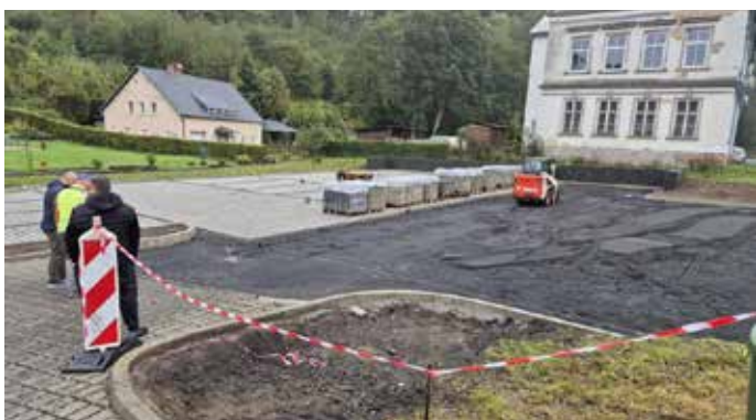
V říjnu proběhla pokládka dlažby na parkovišti v Krásném Buku.
