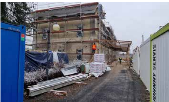
Dalším rokem pokračovala rekonstrukce krásnolipského nádraží.
