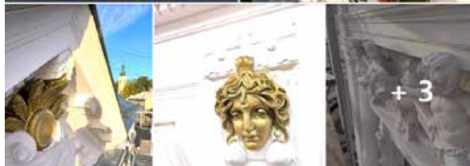
Ukázka opravy ozdobných detailů na radniční fasádě.
