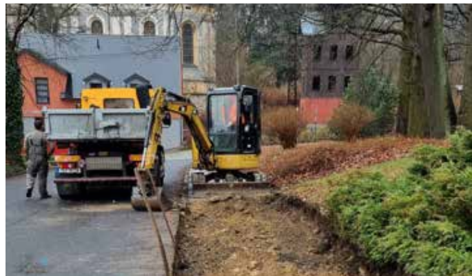
Byla zahájena rekonstrukce chodníku ve spodní části sídliště v Nemocniční ulici.
