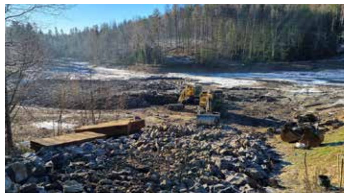
Rekonstrukce Kyjovské přehrady byla zahájena pečlivým odbahněním, odtěženo bylo více jak 8,5 tis. m 3 sedimentu.
