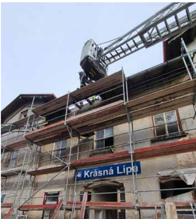
Krásnolipské nádraží prochází rozsáhlou rekonstrukcí
