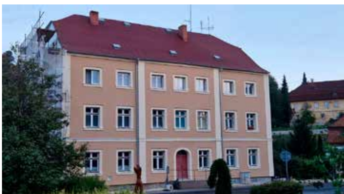
Zateplení a nová fasáda jsou součástí energetických úspor u bytového domu Dittrichova 2
