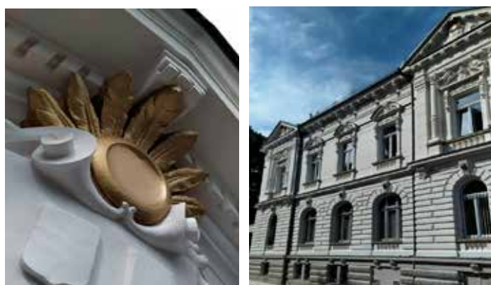
Zahájili jsme postupnou opravu fasády na radnici
