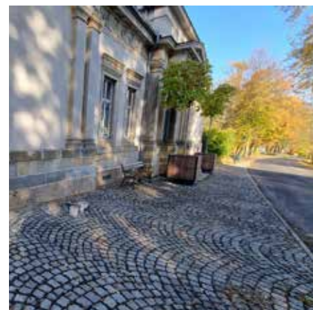
Dokončili jsme opravy kaple na hřbitově, opravili jsme podezdívku a doplnili jsme mobiliář
