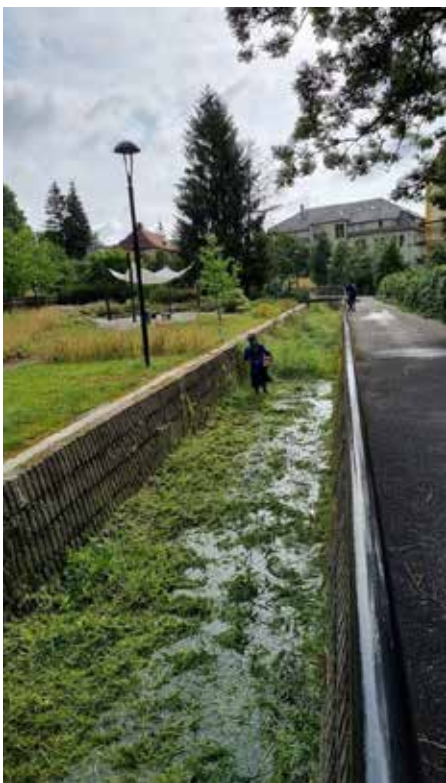
Jako součást protipovodňových opatření proběhlo čištění koryta Křinice od vegetace
