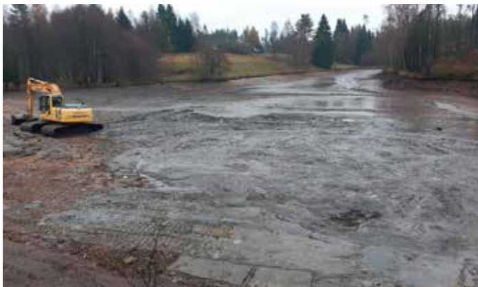
Zahájení prací na odbahnění Kyjovské přehrady
