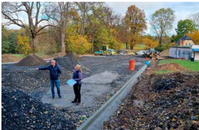
Budujeme parkovací stání pro obytná vozidla, která parkují na nevhodných místech v přírodě i ve městě
