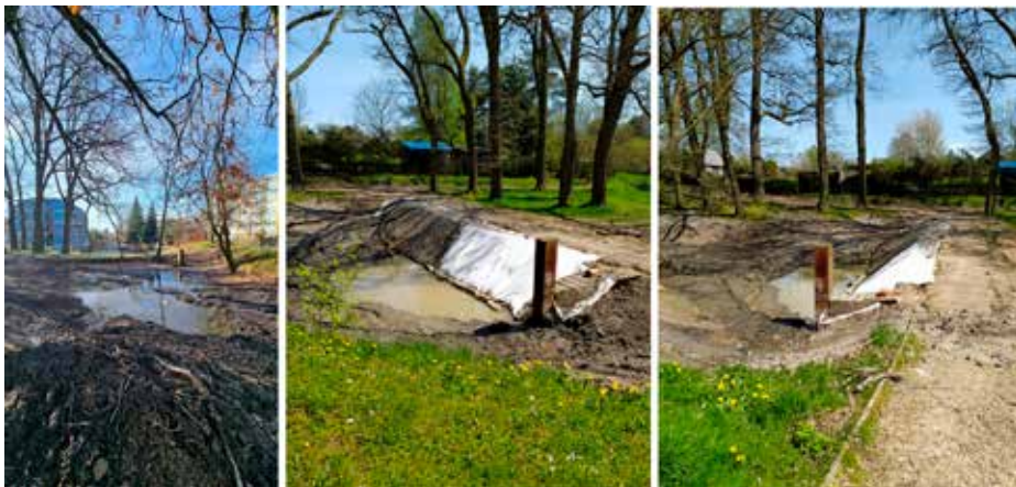
Udržovací práce na rybníčku v sídlišti provedli naši pracovníci TS
