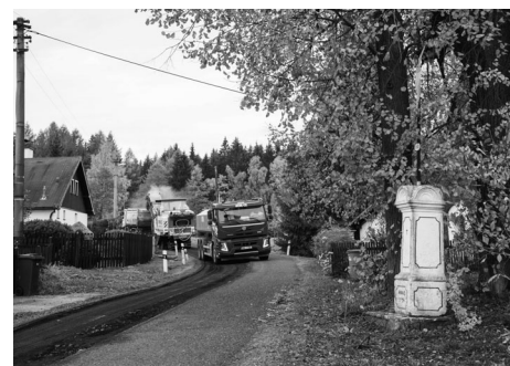
Ústecký kraj opravuje povrch na komunikaci III. třídy vedoucí z Krásné Lípy do Doubice. Fotografie z probíhajících prací 1. listopadu 2018.
