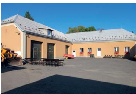
Dílny a zázemí TS po výměně vrat a rekonstrukci fasády
