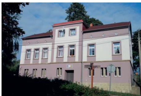
Bytový dům v Mánesově ulici dostal nový kabát
