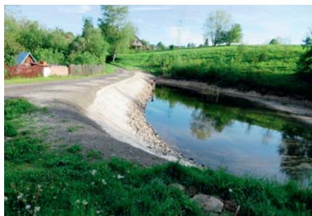
Věnovali jsme se údržbě rybníků, zpěvnili jsme hráze Smutňáku a rybníku v sídlišti
