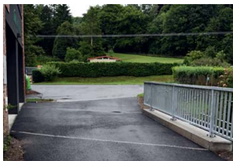
Kompletně jsme zrekonstruovali mostek v ulici Tylova
