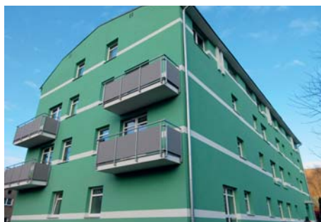
Bytový dům v Nemocniční 6 prošel kompletní rekonstrukcí - nová okna, zateplení a fasáda
