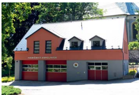
V roce 2015 byla dokončena rekonstrukce hasičské zbrojnice
