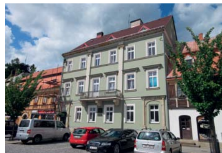
Rekonstrukcí prošla fasáda domu na Křínickém náměstí 16
