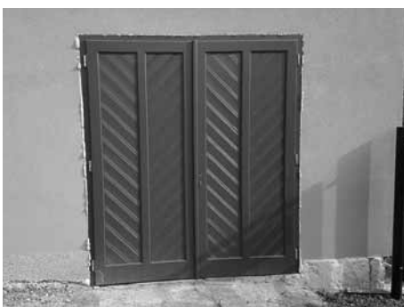
Bytový dům v Mánesově ulici má nejen novou fasádu, ale nyní i nové dveře.
