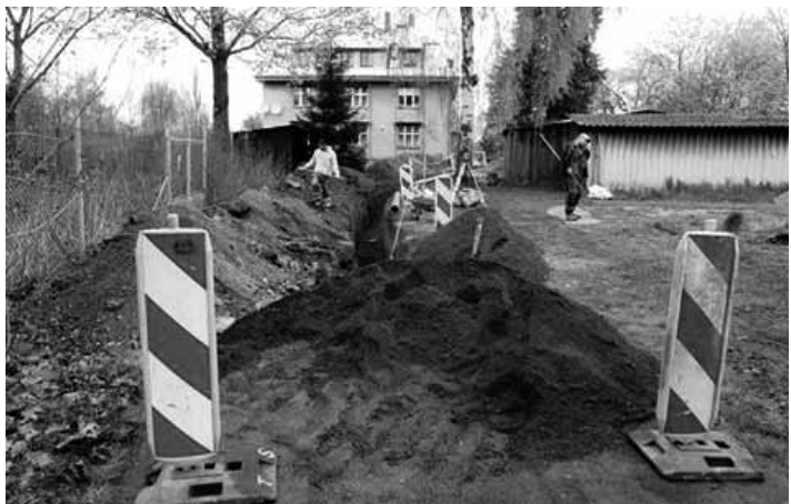
Napojujeme, prostřednictvím našich TS, k nové kanalizaci další bytový objekt v majetku města - tentokrát Rumburskou č. 5.
