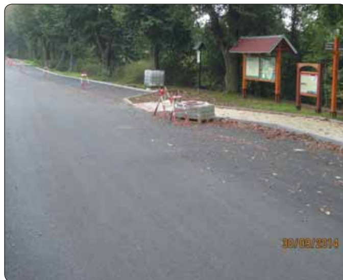
Komunikace u nádraží už je v novém vč. autobusové zastávky, infopanelů a podélných stání
