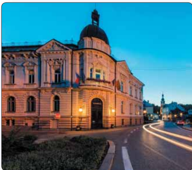
Budova radnice má novou střechu a interiéry úřadu vč. zateplení
