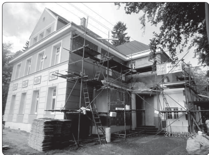
Dodělavá se již poslední strana zateplení a fasádních prvků objektu první mateřské školy
