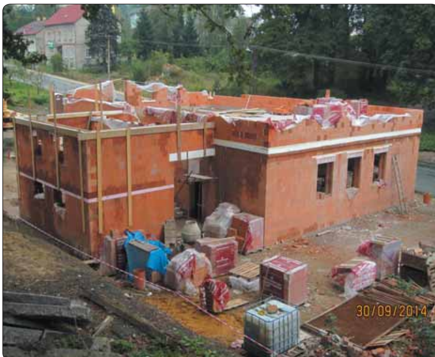
Rekonstrukce či vlastně spíše výstavba nové požární zbrojnice již pokračuje rychle
