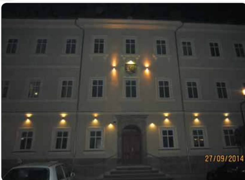
Objekt Křínické náměstí 1 _ nová okna, fasáda, osvětlení, městský znak
