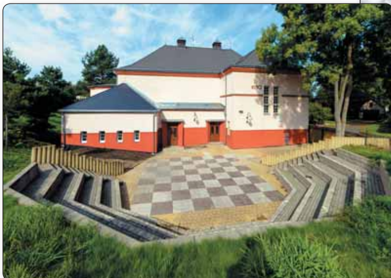
Přístavek kulturního domu umožňuje boční vstup na jeviště a rozšíření zázemí pro kulturní akce
