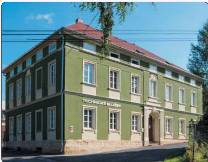
Areál Technických služeb prochází postupnou modernizací
