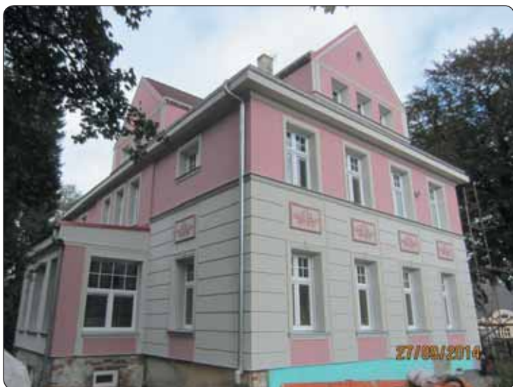
Hlavní části zateplení a fasády mateřské školy v ulici Smetanova je z velké části hotova
