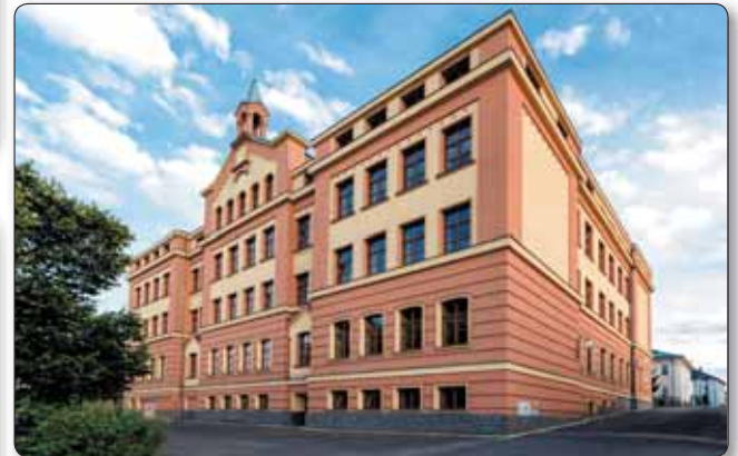
Opravená budova základní školy v Krásné Lípě
