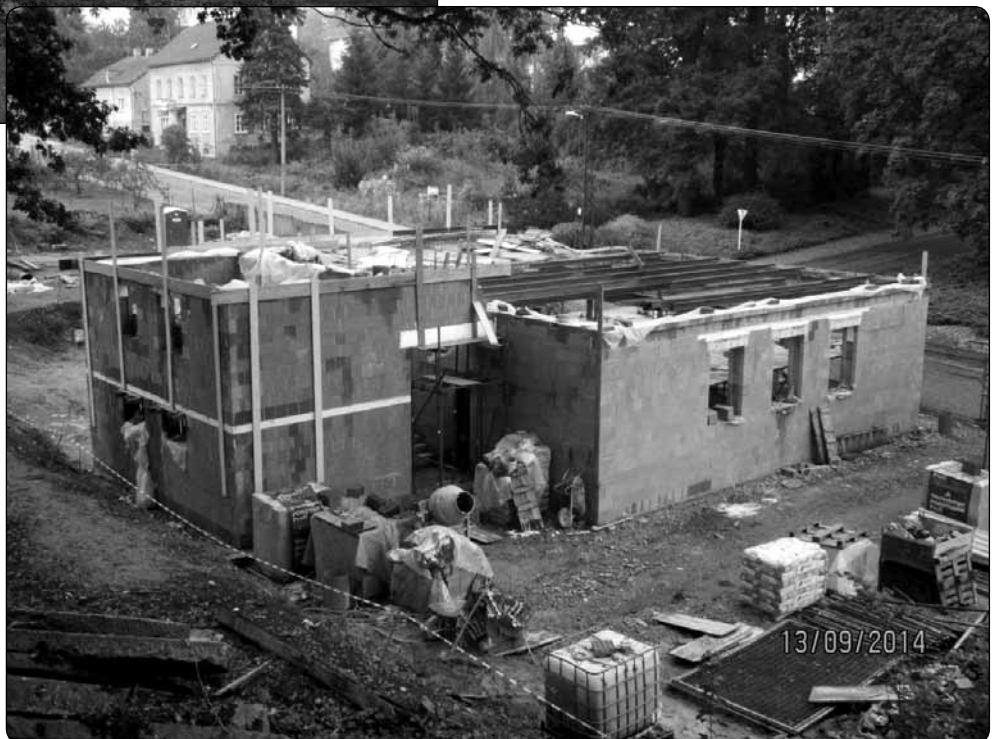
Rekonstrukce požární zbrojnice bude pokračovat zalitím stropu železobetonem
