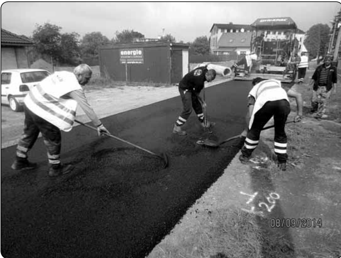
Asfaltování komunikací po vystavbě kanalizace, zde Lidická
