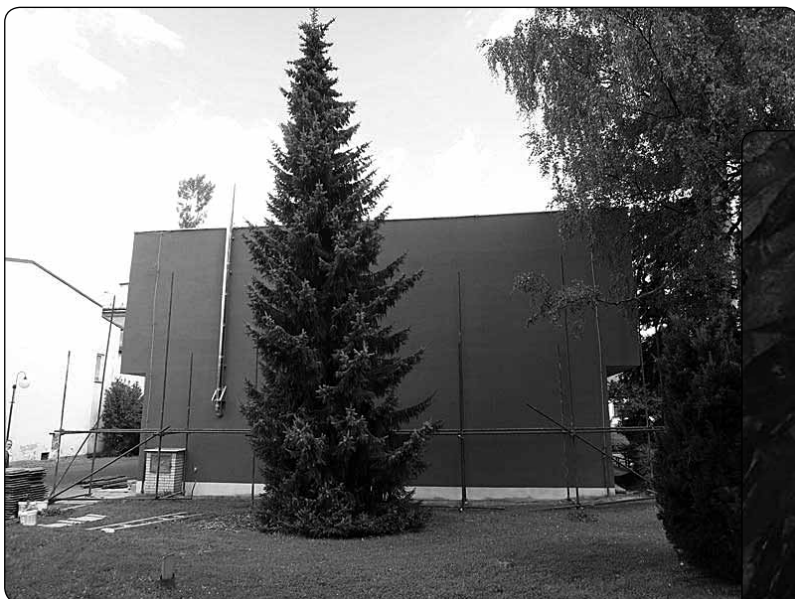
Dům služeb - zadní stěna. Už se nám to vybarvuje, brzy už bude i zde hotovo.
