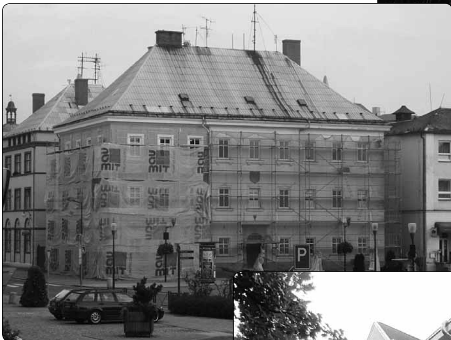
Nová okna, oprava fasády - provádí firma Uni-plast z Háje u Duchcova, opravu pískovcového soklu realizuje krásnolipský Miloš Kubišta. To vše na Křínickém náměstí 1.
