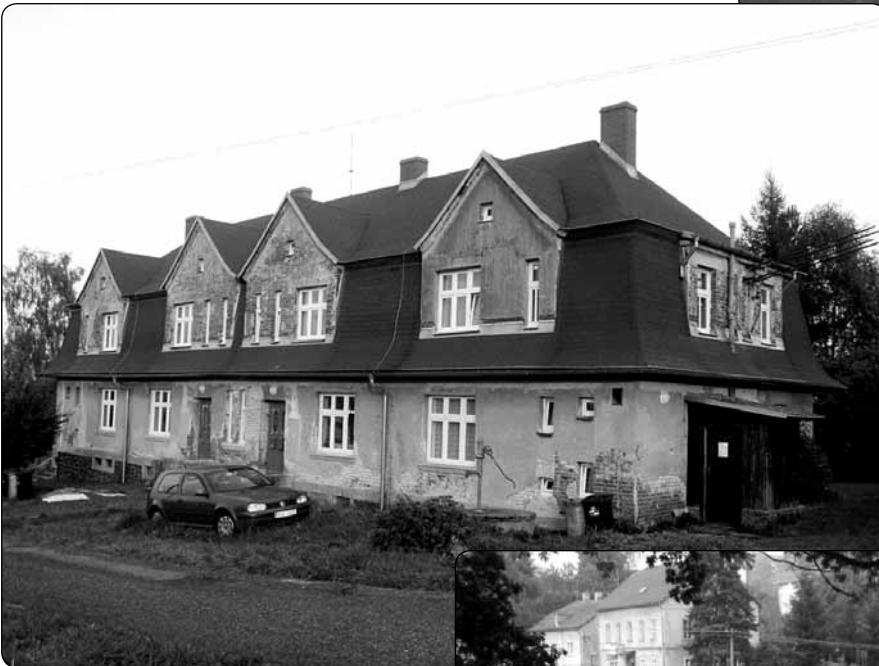
Po nové střeše dostal dům Bezručova 15 i nové okna a příští rok novou fasádu
