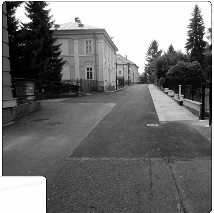
Nový plot u školní družiny a nově opravená ulice Komenského
