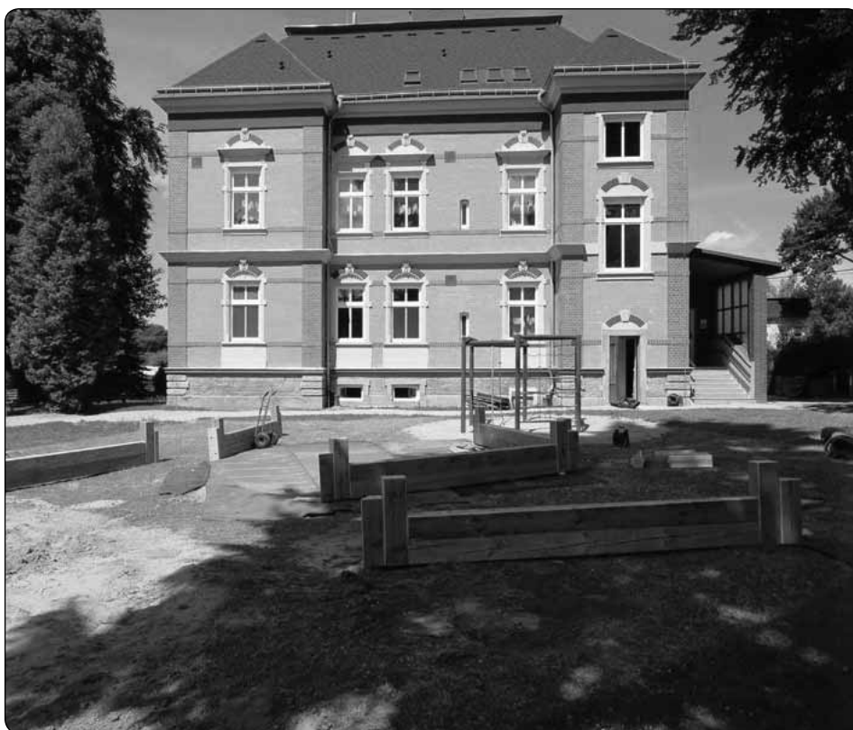
Naše TS provádí úpravu zahrady MŠ na Masarykově ulici. Budují se nové dopadové plochy pro dětské prolézačky, pískoviště a repasují se další herní prvky.
