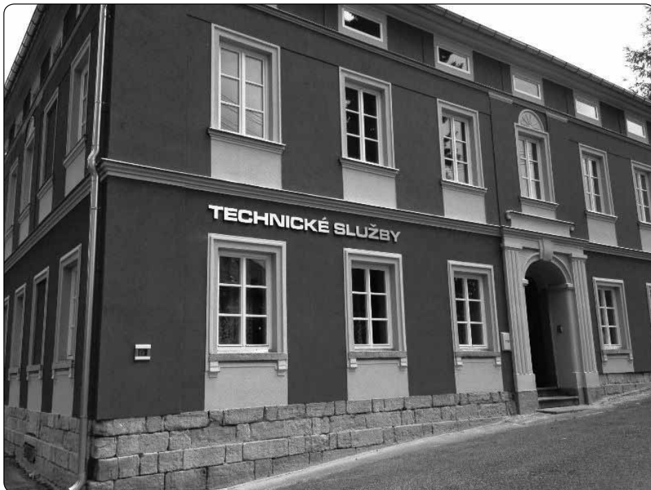
Budova TS dostala nové označení. To snad kdyby byl někdo na pochybách, že je to pořád ten samý dům.
