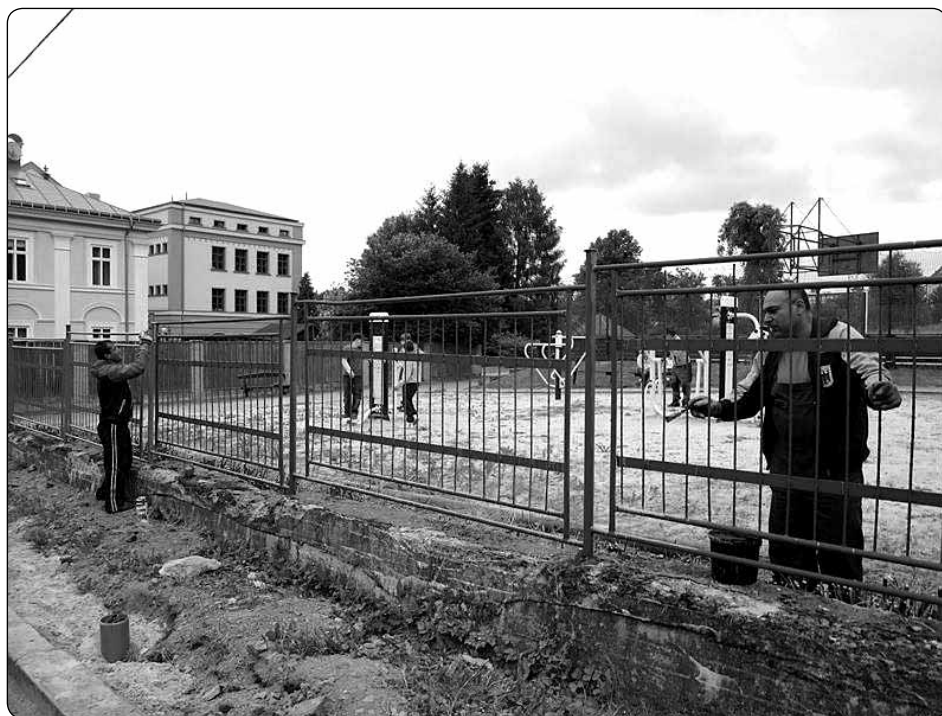
V Komenského ulici u základní školy probíhají úpravy chodníků, veřejného osvětlení a povrchu komunikace. Zároveň se natírá oplocení Hauserky. Na část aktivit město využívá pracovníků veřejně prospěšných prací.
