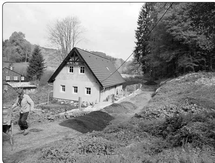
TS opravují místní komunikaci v Dlouhém Dolu.
