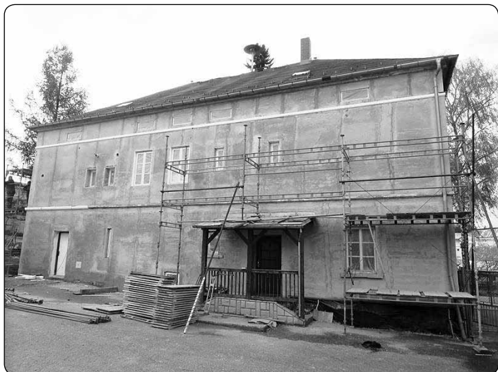
Práce na fasádě technických služeb rychle postupují. Za měsíc by mělo být hotovo, pak se dozvíme, jak skutečně bude fasáda vypadat.
