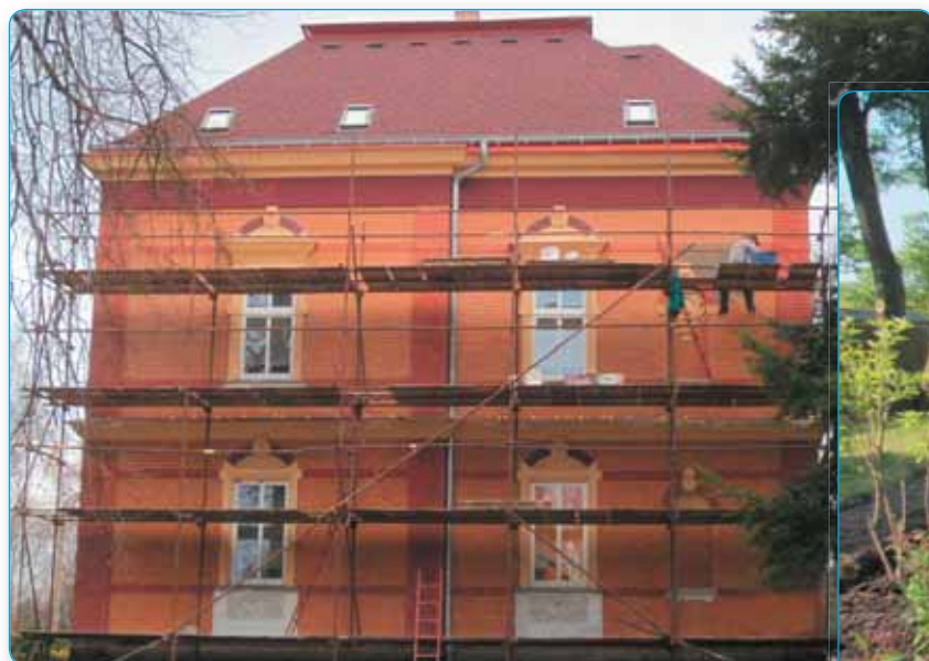
Započala oprava fasády 2. mateřské školy Masarykova
