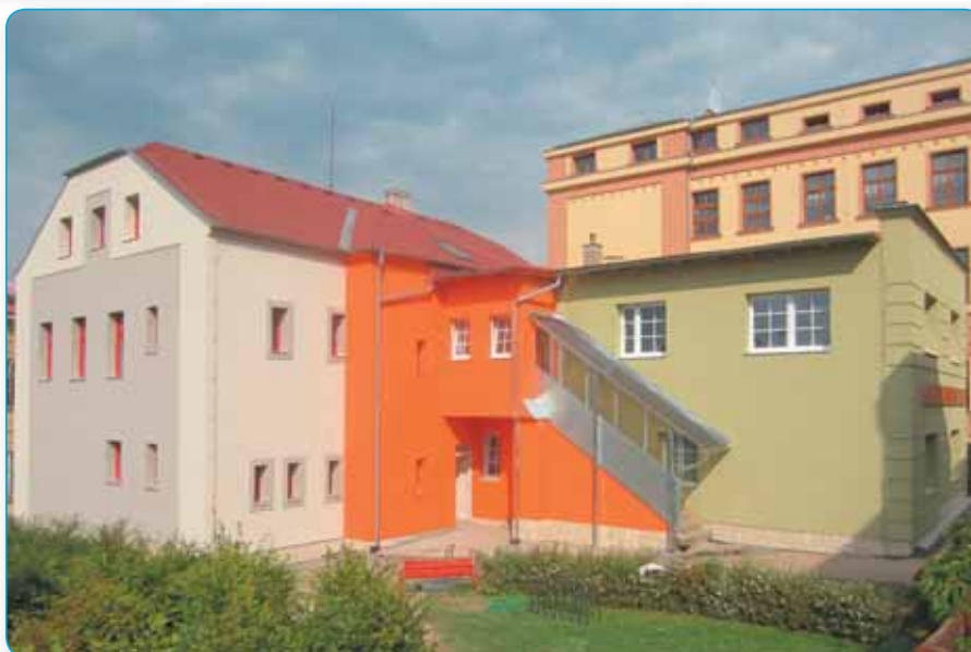
Školní jídelna je po rekonstrukci k nepoznání
