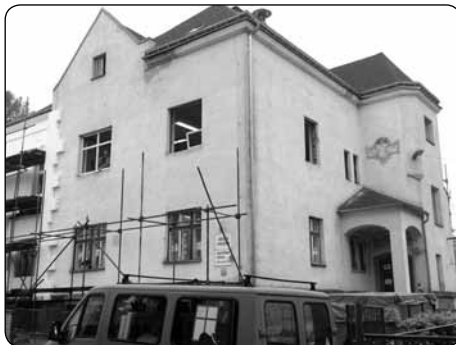
Na vnějším plášti objektu školní družiny se připravuje zateplovací systém a vyměňují okna
