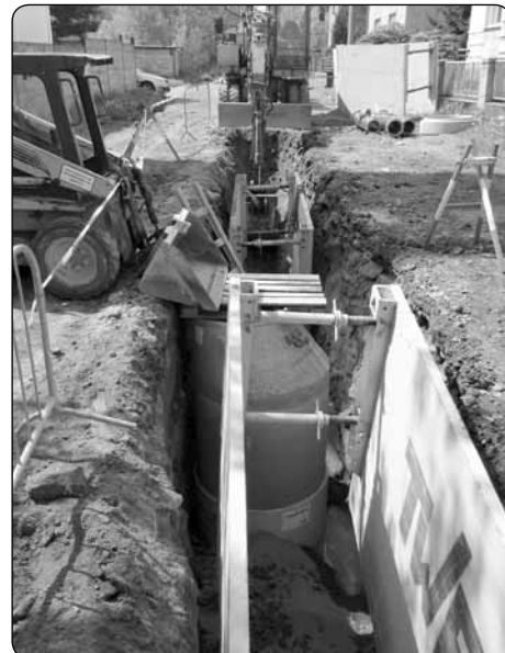
Postup prací na kanalizaci komplikují stávající sítě a jejich opravy, především vodovody
