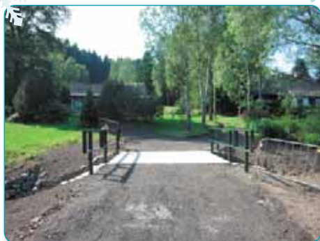
Proběhla obnova čtyř mostků přes Křinici
