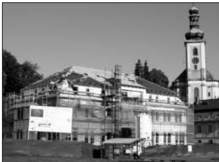
Hrubá stavba infocentra se rychle kompletuje o střešní krytinu, zatepovací systém a okna. Na podzim by měla být větší část vnějších prvků včetně fasády tak, aby mohly intenzivně probíhat práce uvnitř objektu.
