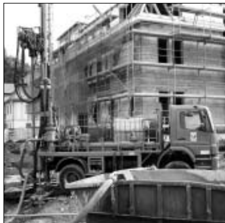
U nového domu infocentra na náměstí probíhají práce na vrtání devíti vrtů hlubokých sto deset metrů, které umožní dům vytápět anebo chladit.
