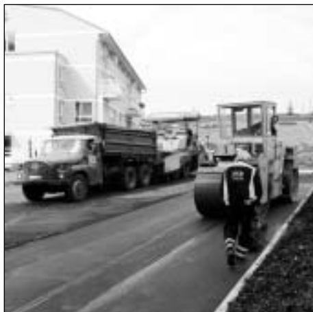
Na sídlišti u nového domu s pečovatelskou službou se dokončuje nové parkoviště pro cca 20 automobilů.
