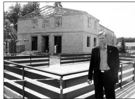
Primátor Ústí nad Labem Jan Kubata na sportovním areálu. V pozadí je vidět dokončovaná fasáda na tělocvičně, hrubá stavba přístavby a dětský hrad.
