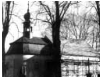
Podzim roku 2003, II. etapa opravy dokončena
