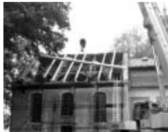
Podzim roku 2003, doprava trámu pomocí autojeřábu
